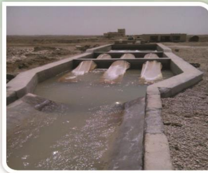
استفاده از فیلترهای مناسب و متعدد جهت تصفیه فیزیکی آب
