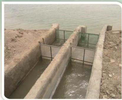
استفاده از فیلترهای مناسب و متعدد جهت تصفیه فیزیکی آب
